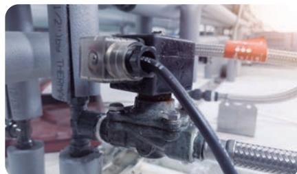
Electroválvulas de 1" entre depósitos y lavadoras y entre bombas y depósitos.
